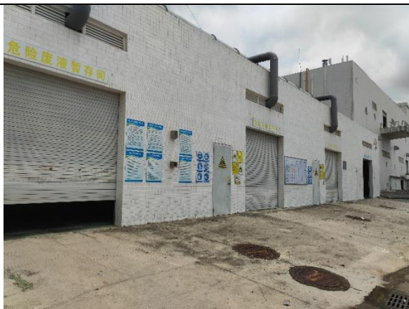
项目红草园区危险废物仓库
