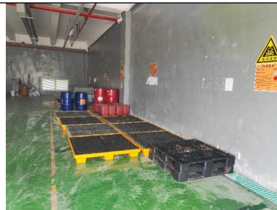
项目红草园区危险废物仓库内部暂存危废及相关标识
