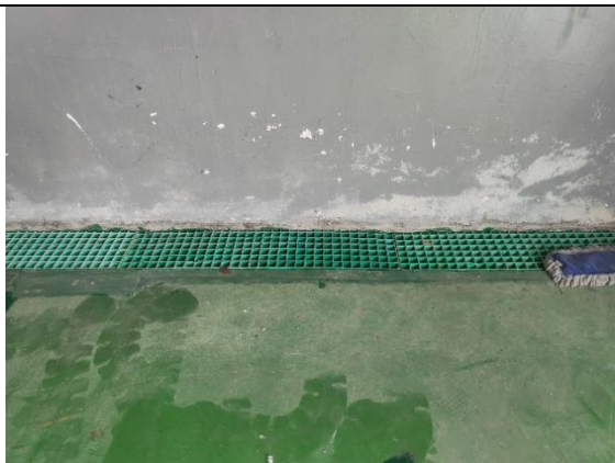
项目红草园区危险废物仓库防腐防渗、导流槽及渗沥液收集池
