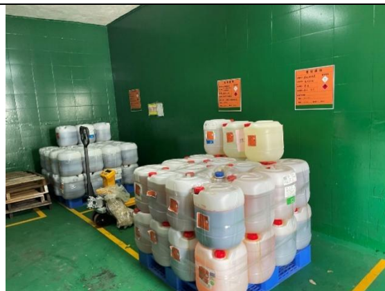
项目工业城危险废物仓库内部暂存危废及相关标识
