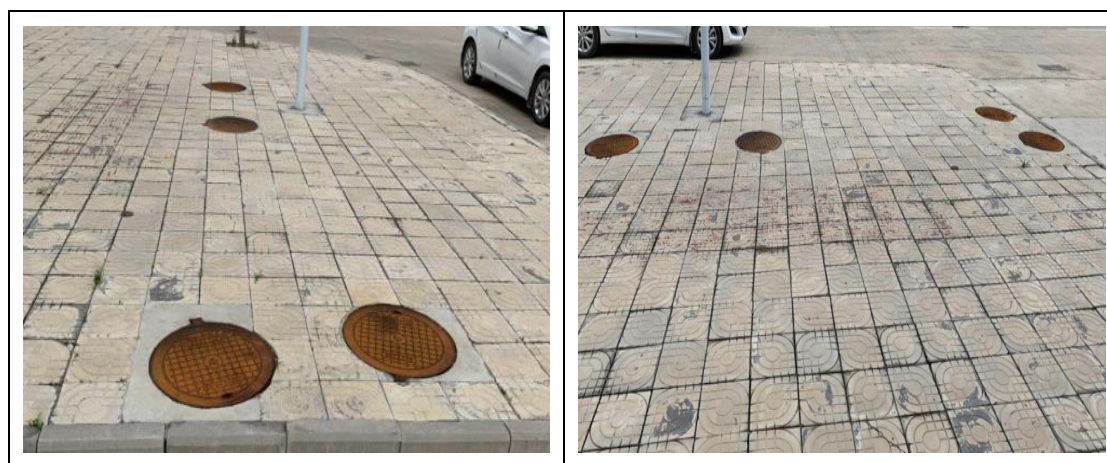
图 1 三级化粪池图片
