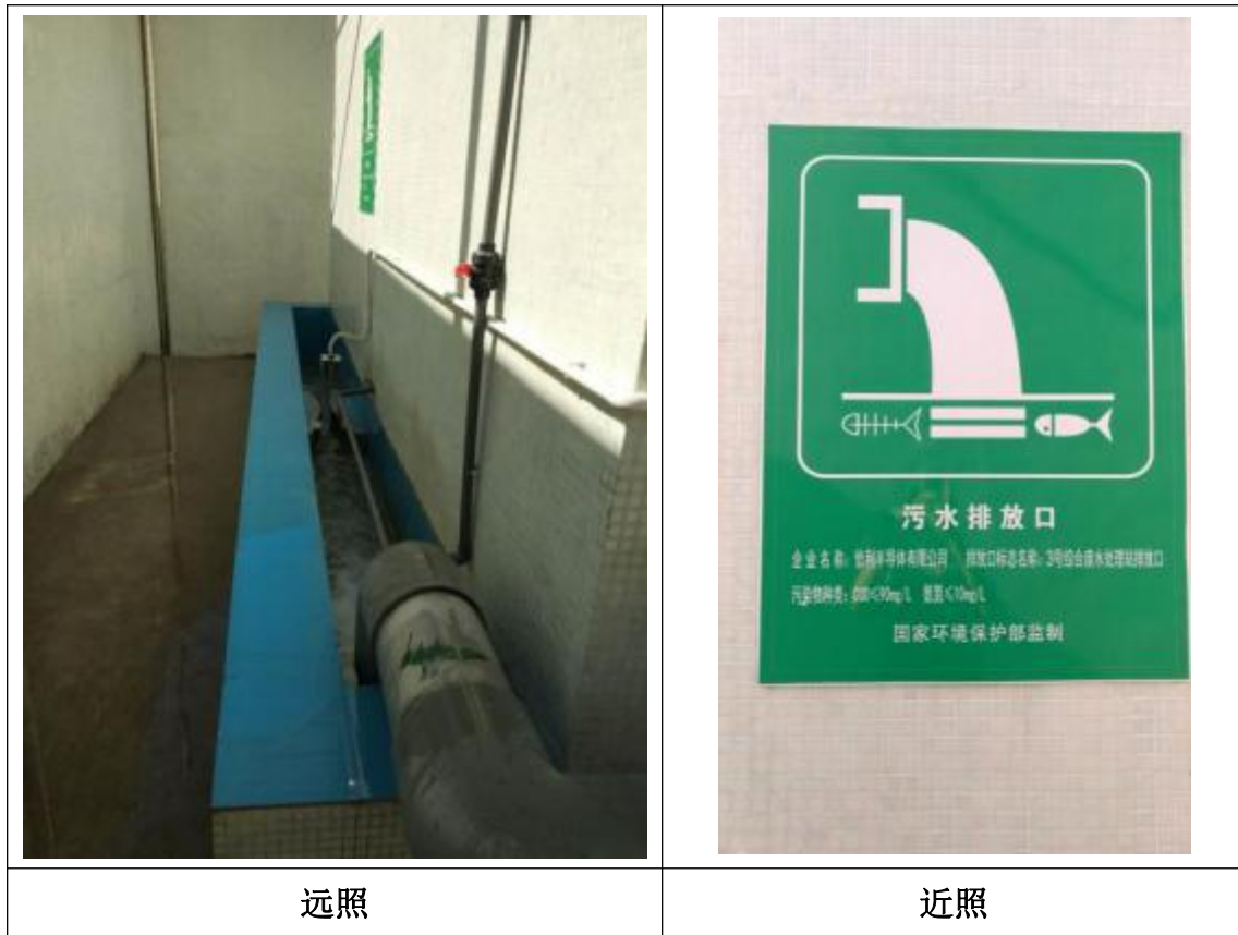
图 4.1-4 3 号废水处理站总排放口的现场图片
