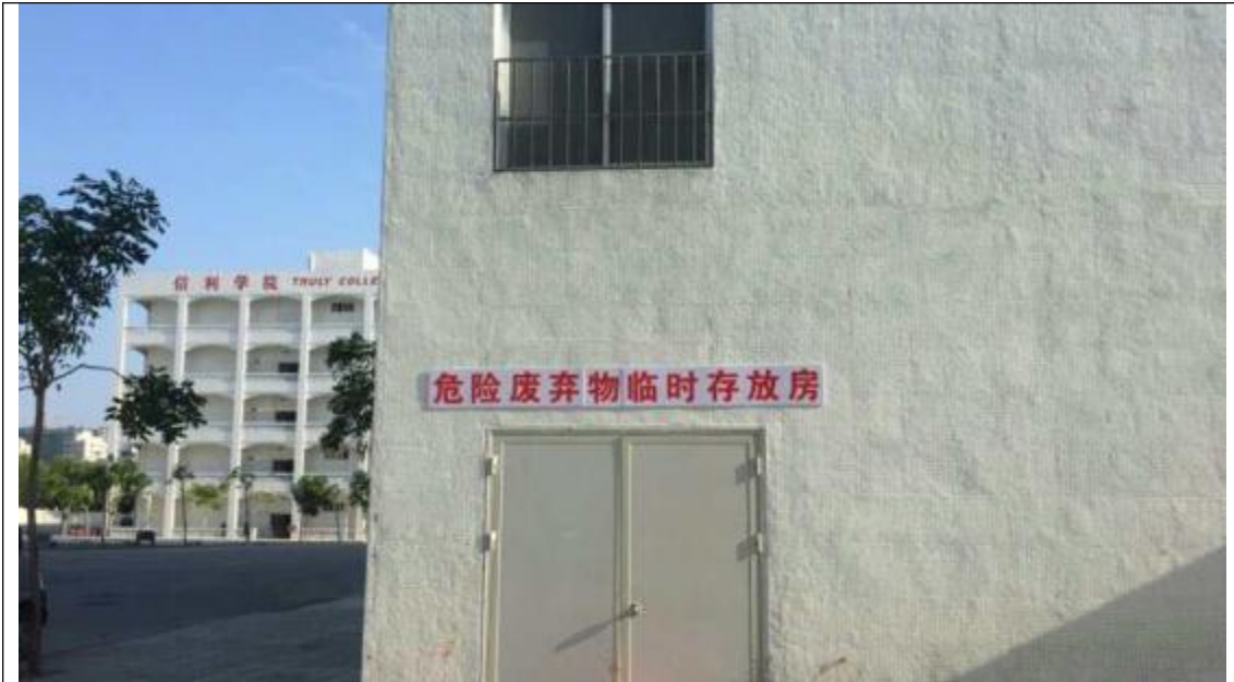
26号厂房危废临时暂存间
