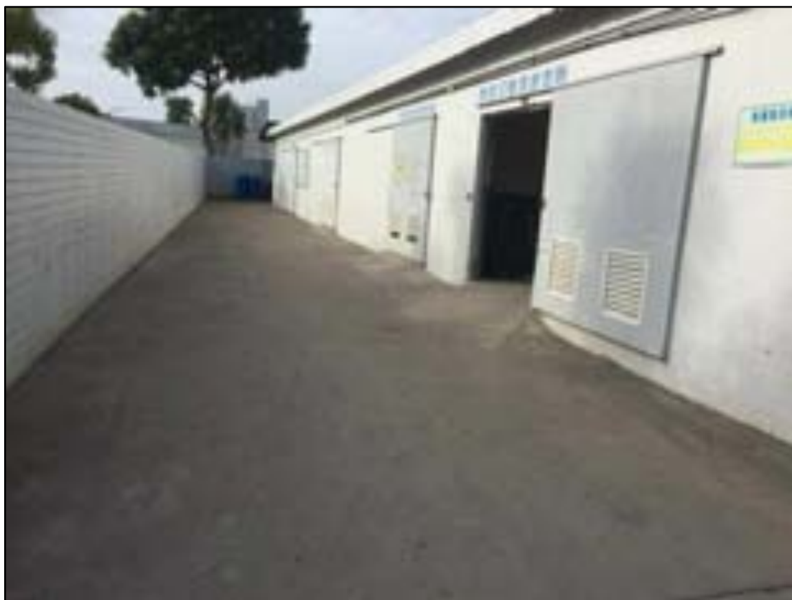
图 4.2-2 危险废物仓库现场照片
