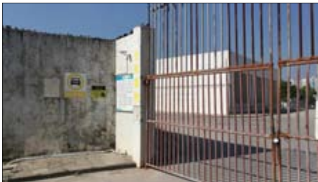
图 4.2-3 危险化学品仓库现场照片
